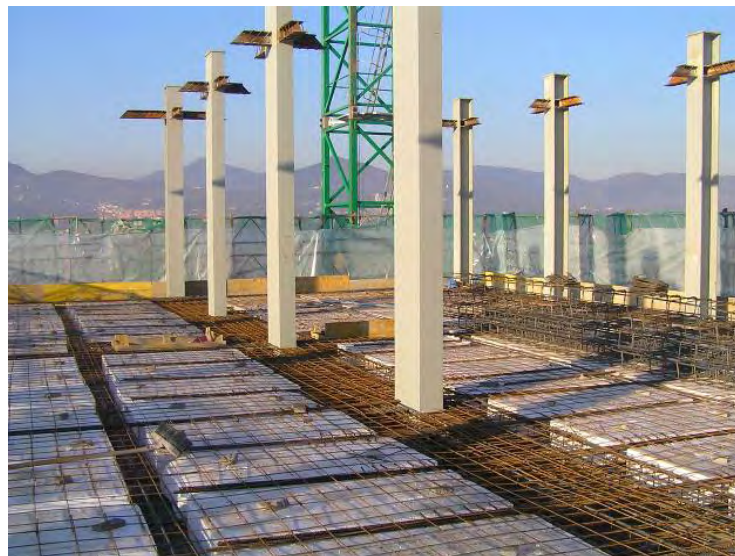
Figura 3.3 Unión entre pilares de acero y las losas de hormigón armado.
