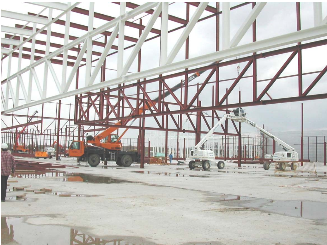
Figura 2.5 Trabajos en obra durante la etapa del montaje de la estructura de acero
