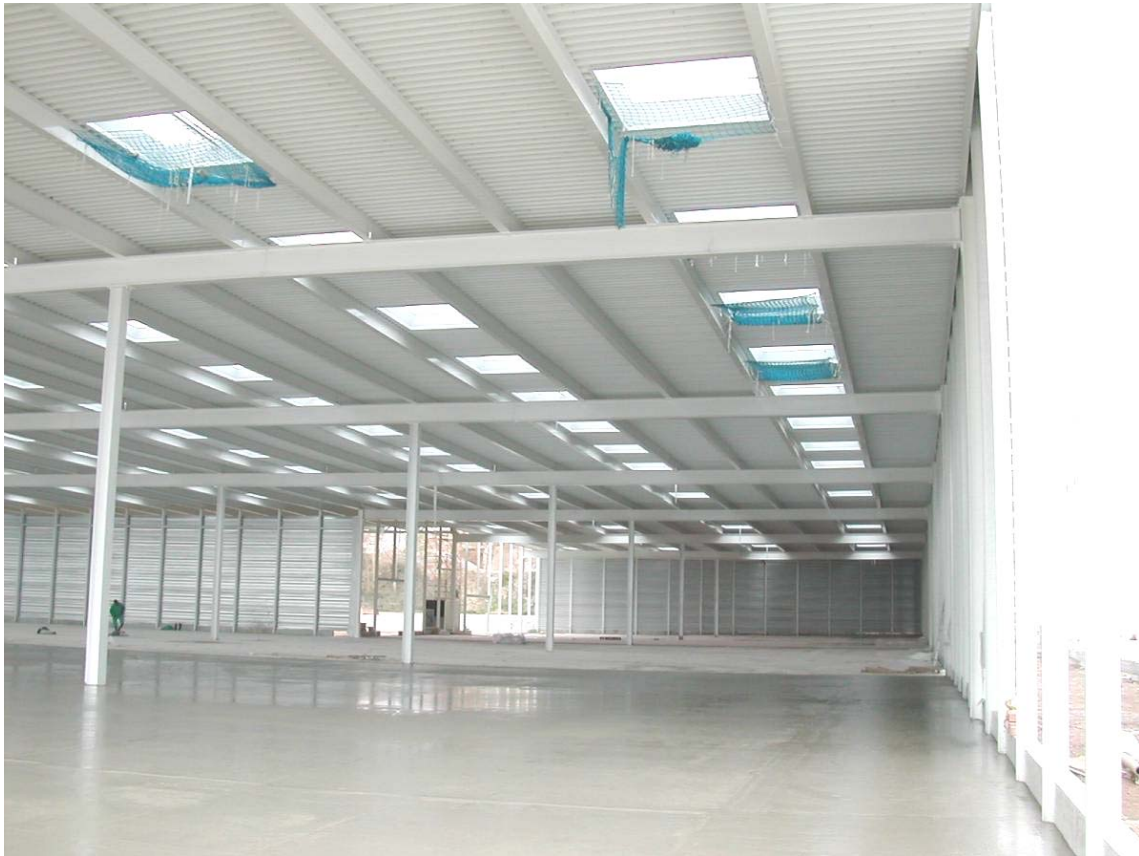
Figura 2.4 Estructura del supermercado durante el montaje
