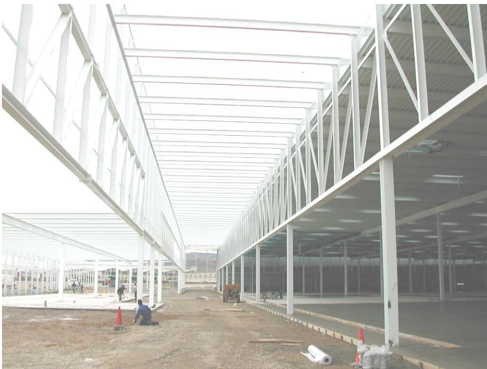
Figura 2.2 Estructura del corredor durante el montaje
