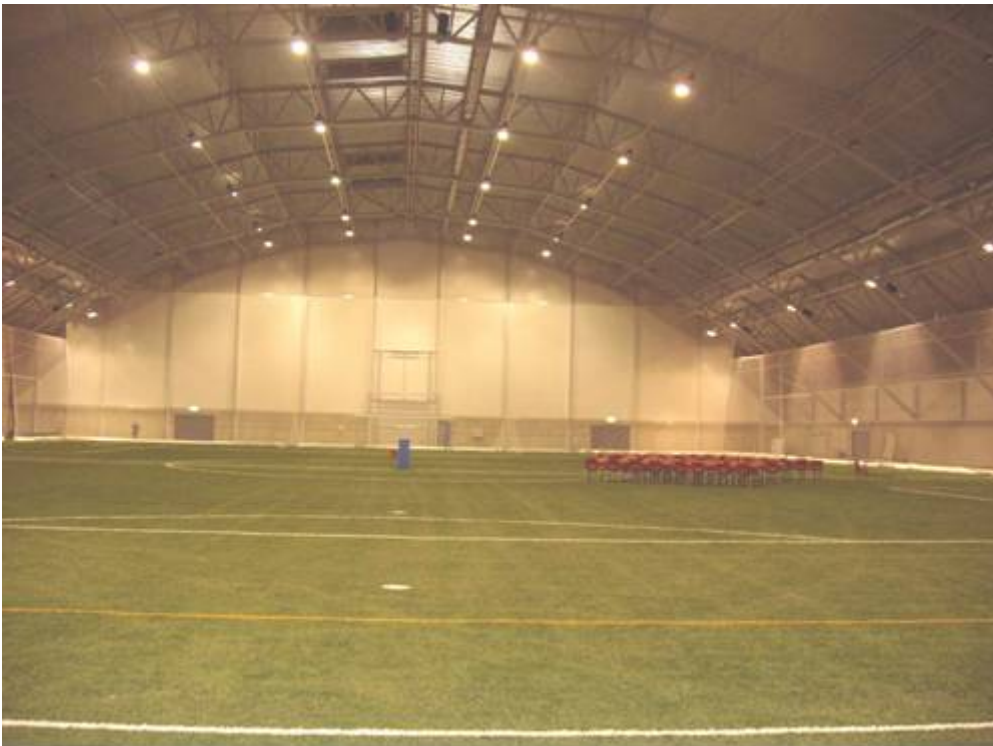
Figura 3.2 Vista interior del estadio de arena cubierto
