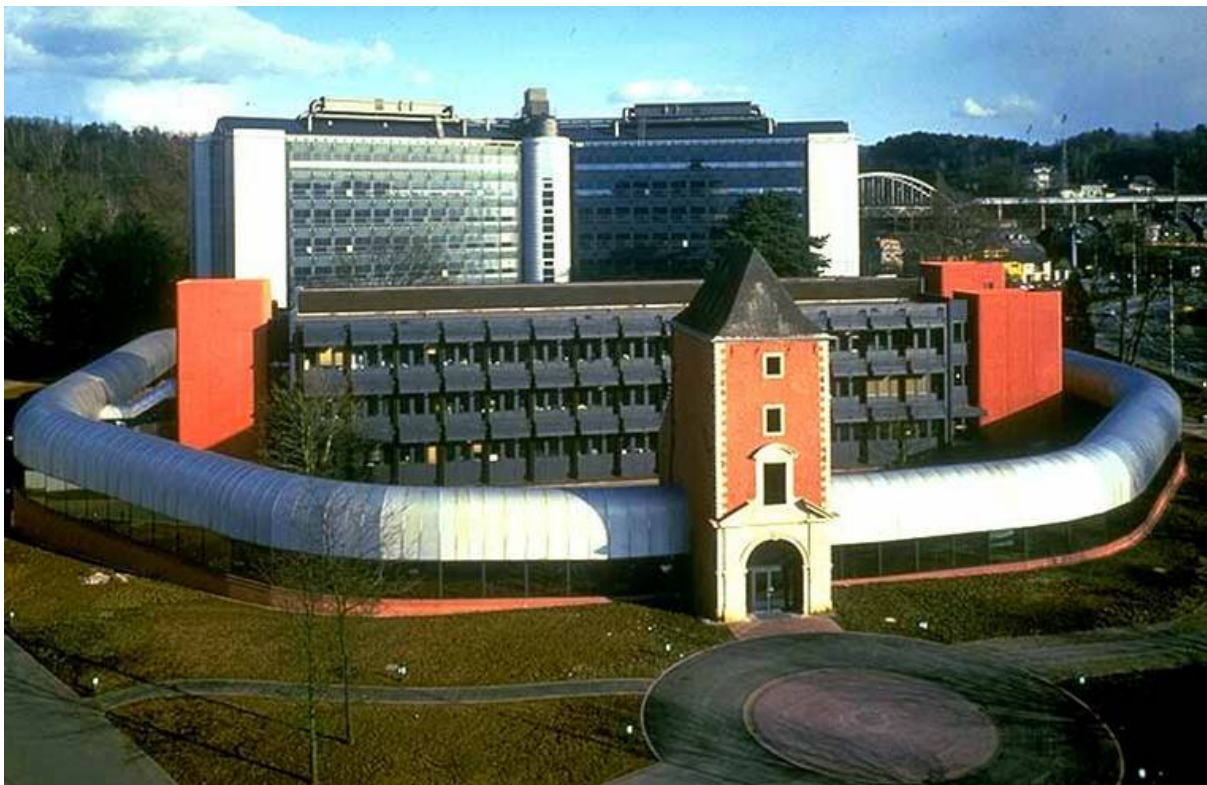
Complejo de oficinas de ProfilARBED, Luxemburgo
