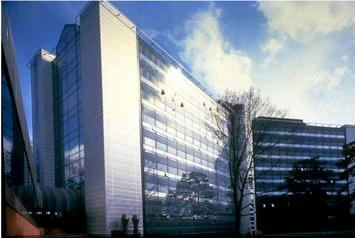
Figura 2.1 Edificio de oficinas de 8 plantas terminado
