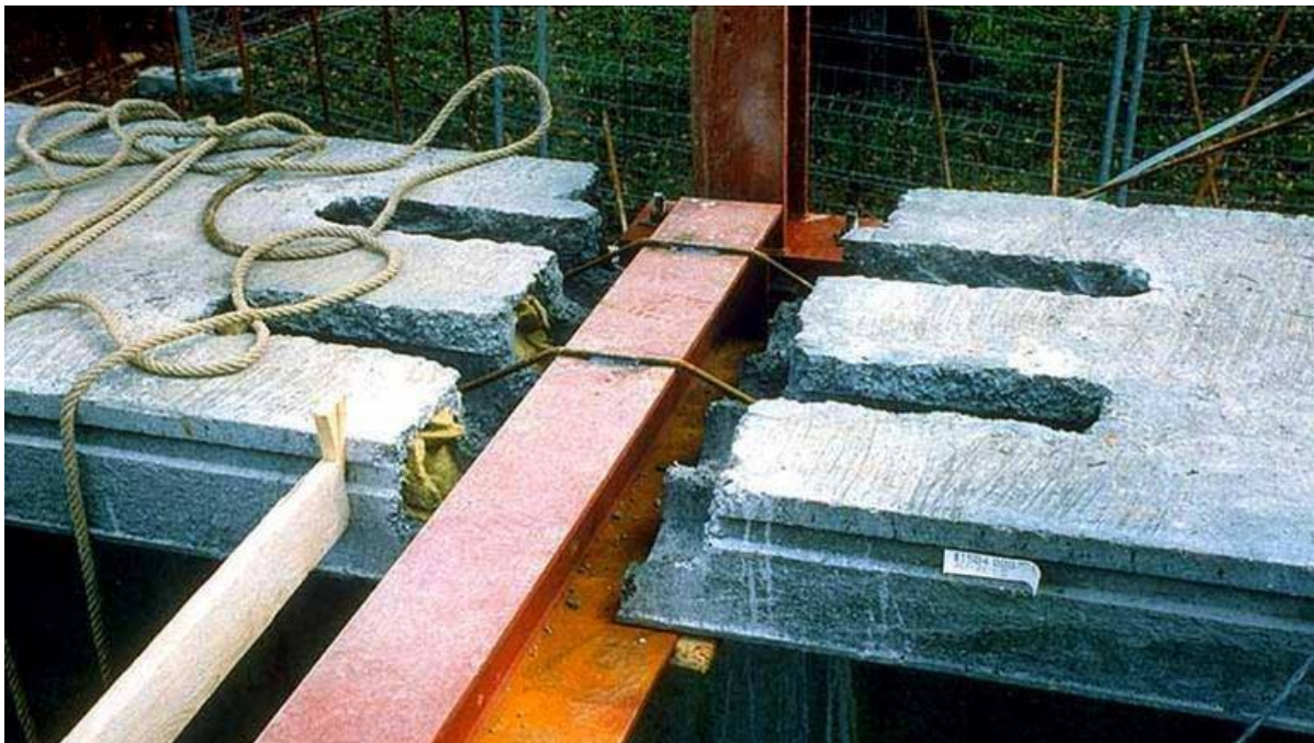
Figura 3.3 Refuerzo contra el fuego en el forjado
