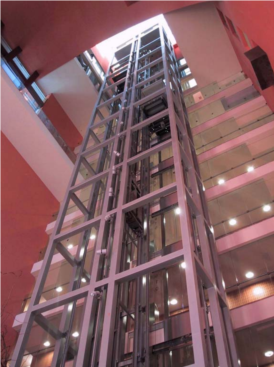
Figura 3.5 Estructura de acero de los ascensores en el atrio.
