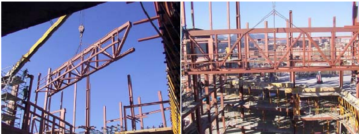
Figura 4.4 Montaje de las celosías encima de la estructura del atrio
