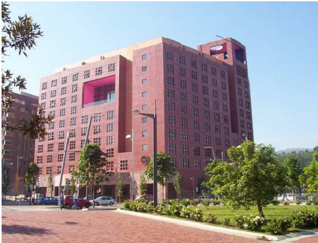
Figura 3.1 Vista de la elevación de la fachada principal.
