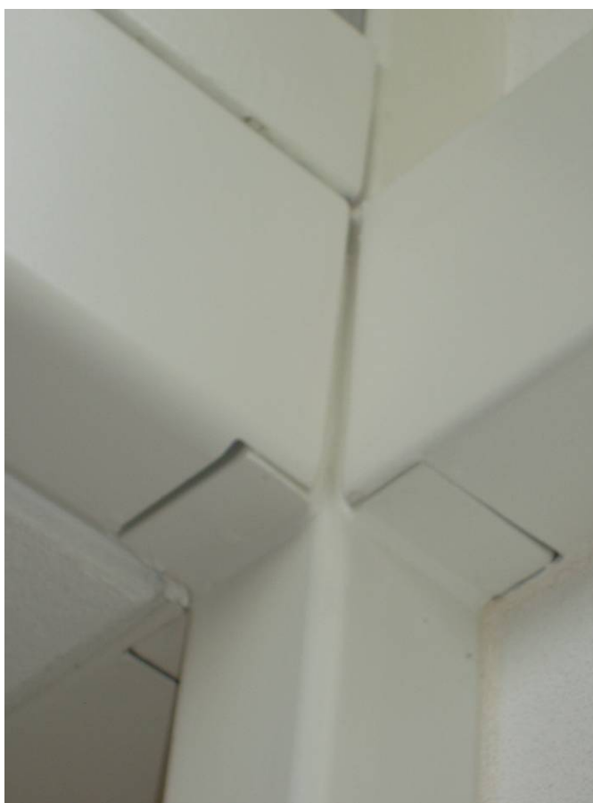
Figura 1.1 Unión tubular 'oculta'
