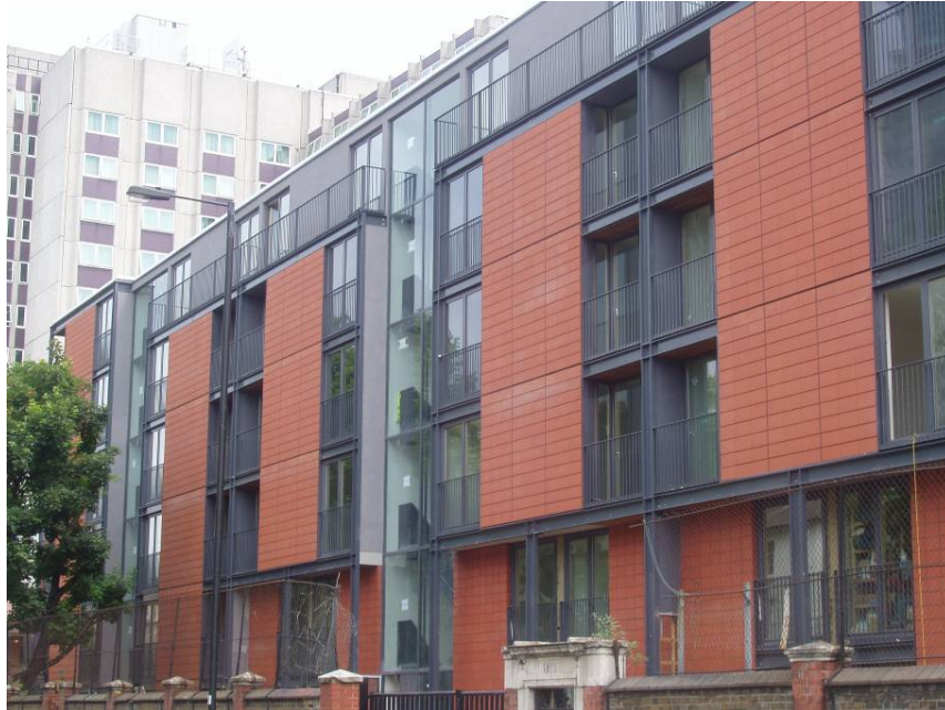
Edificio completado en Lillie Road, Fulham
