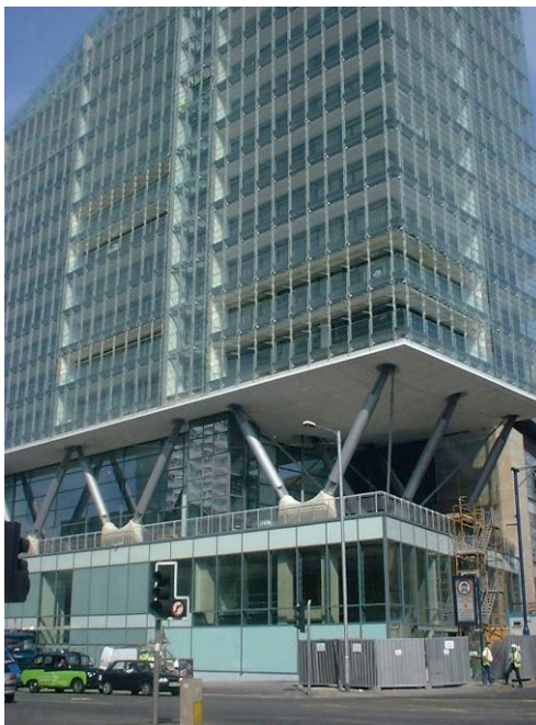
Figura 1.2 Pilares inclinados formando el pedestal
