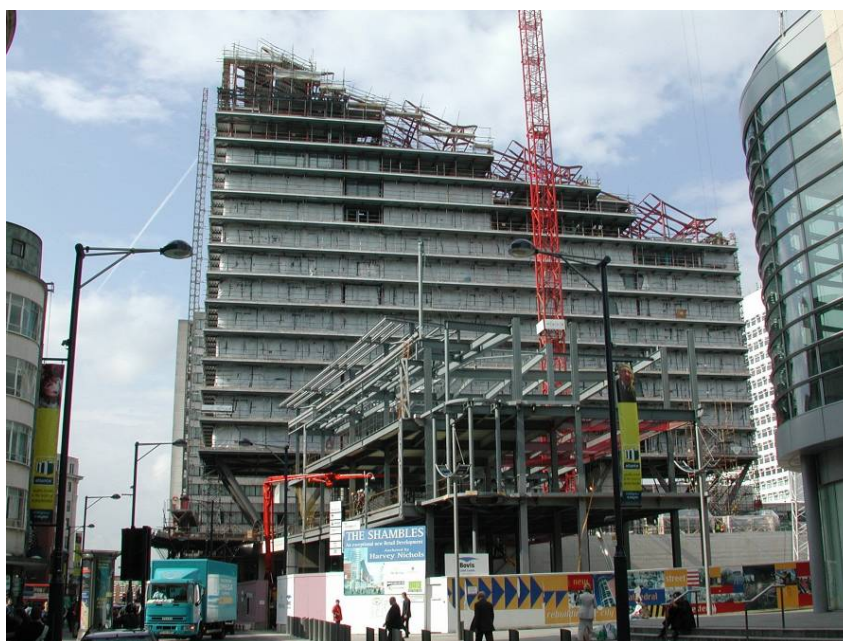
Figura 1.1 Estructura durante la construcción
