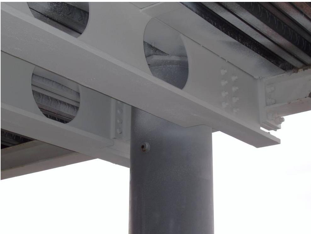
*Figura 2.2 Detalle de unión de las vigas a los pilares tubulares*
