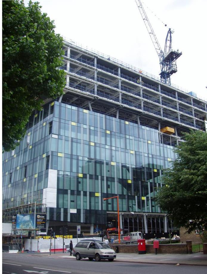
*Palestra durante la construcción, donde se muestra la estructura de acero y la fachada totalmente acristalada*
