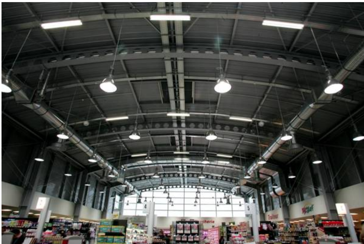
Estructura principal del supermercado
