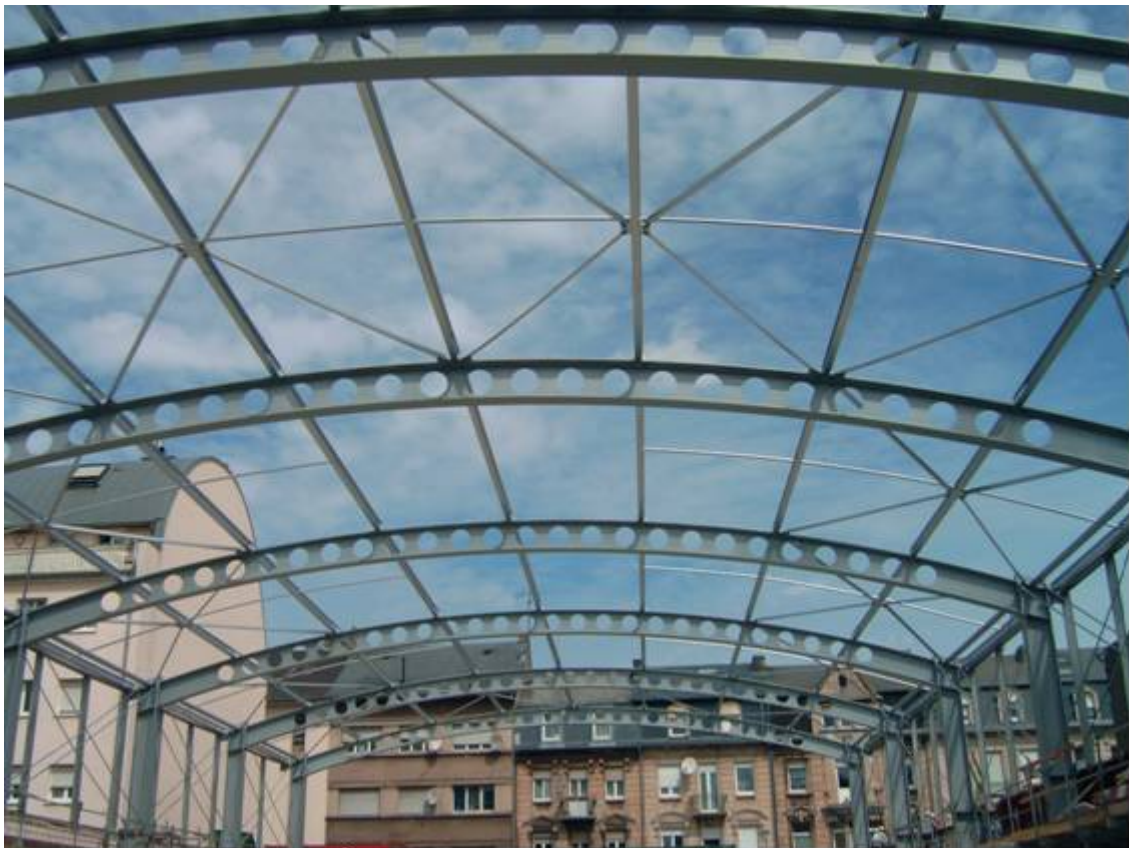
Figura 2.1 Vista del edificio durante la construcción
