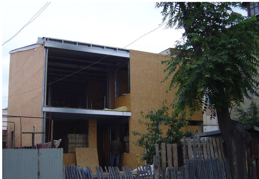
(b) la estructura de acero con todos los paneles OSB portantes montados.
