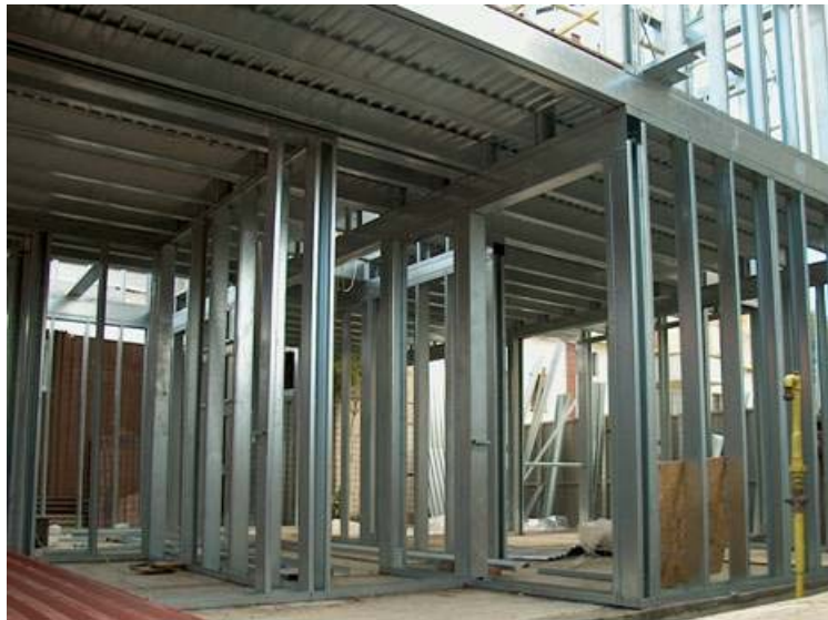
(a) la estructura de acero terminado
