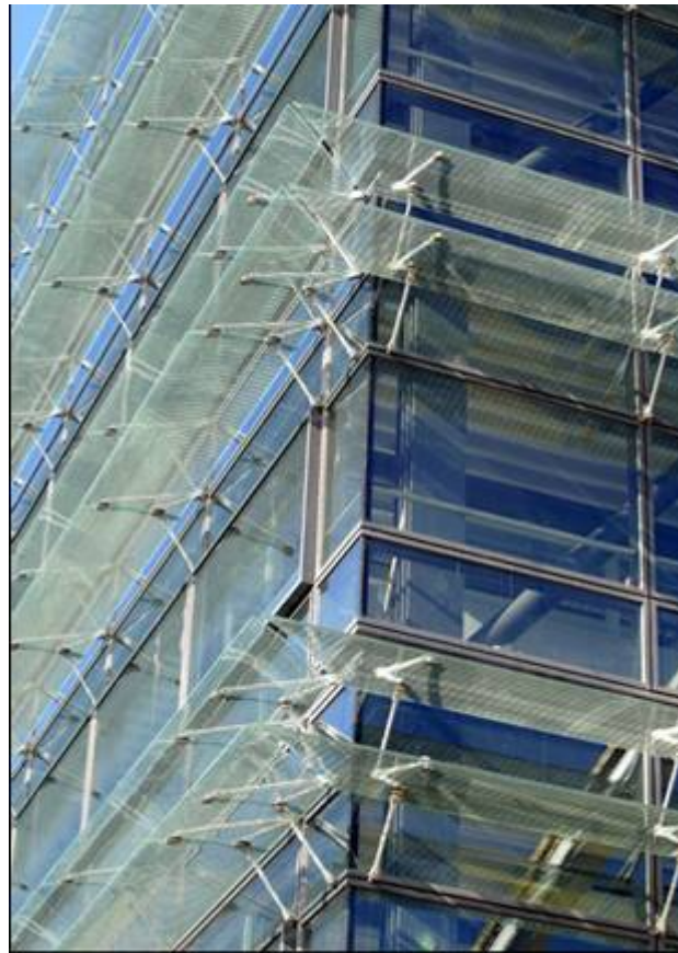
Figura 3.2 Parasoles en la fachada de vidrio
