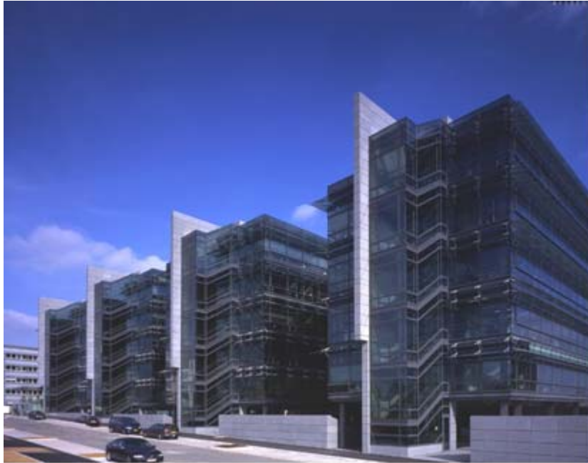
Edificio completo donde se muestra la fachada totalmente acristalada
