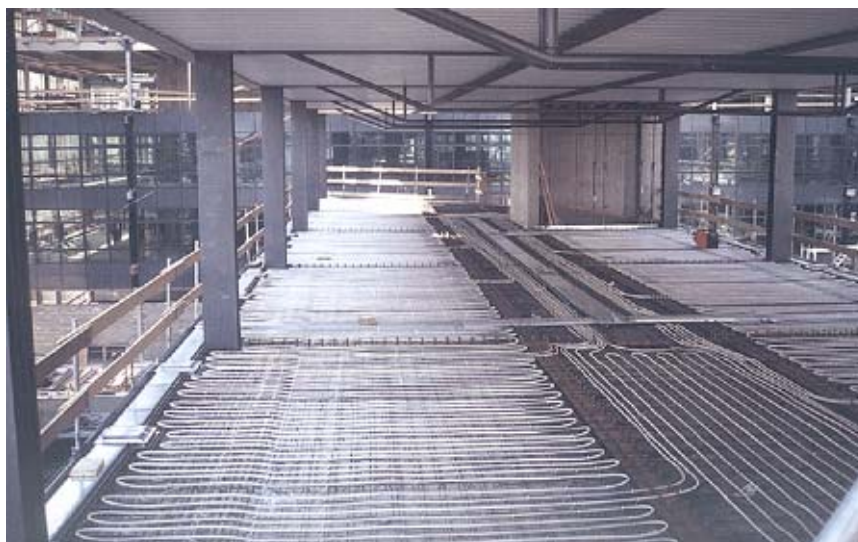
Figura 2.1 Tuberías de calefacción/refrigeración extendidas en la losa del forjado
