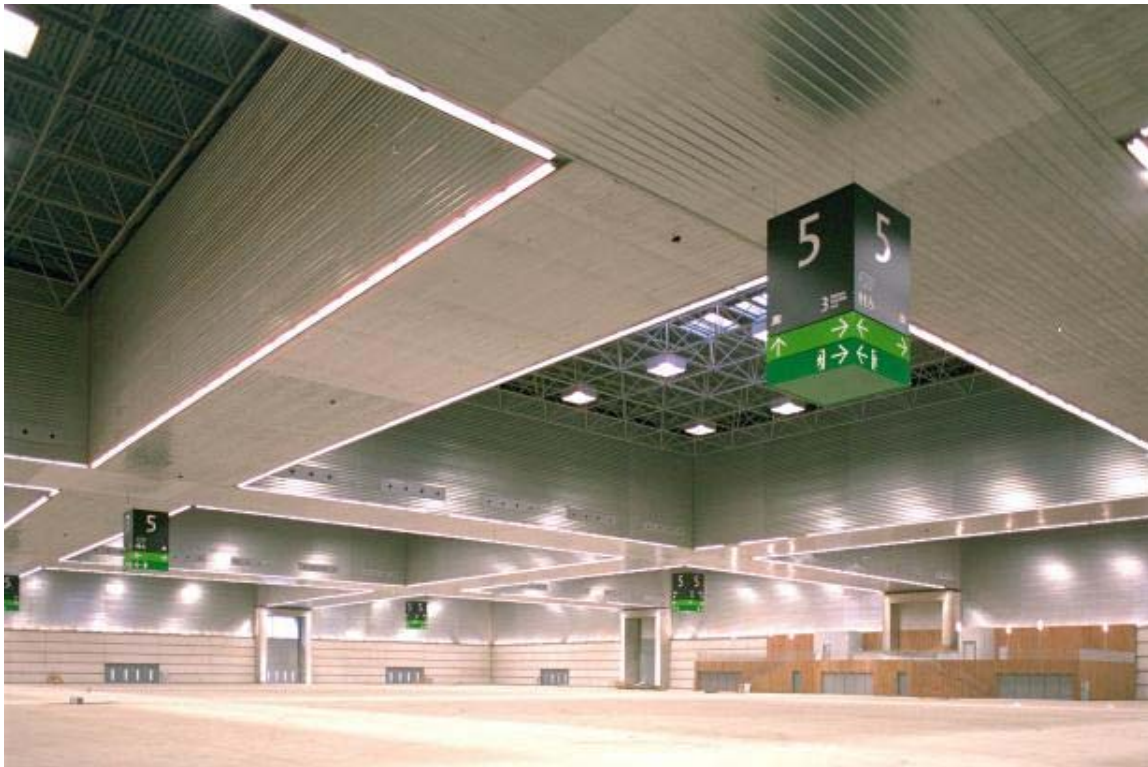
Figura 1.1 Vista interior del Hall n°5
