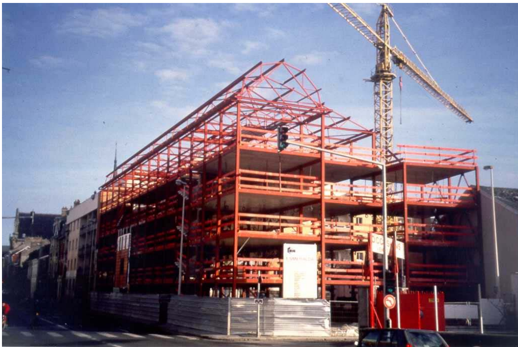
Figura 3.1 Edificio durante su construcción
