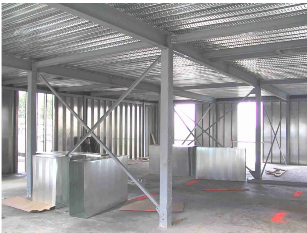
Figura 3.2 Vista interior de la estructura
