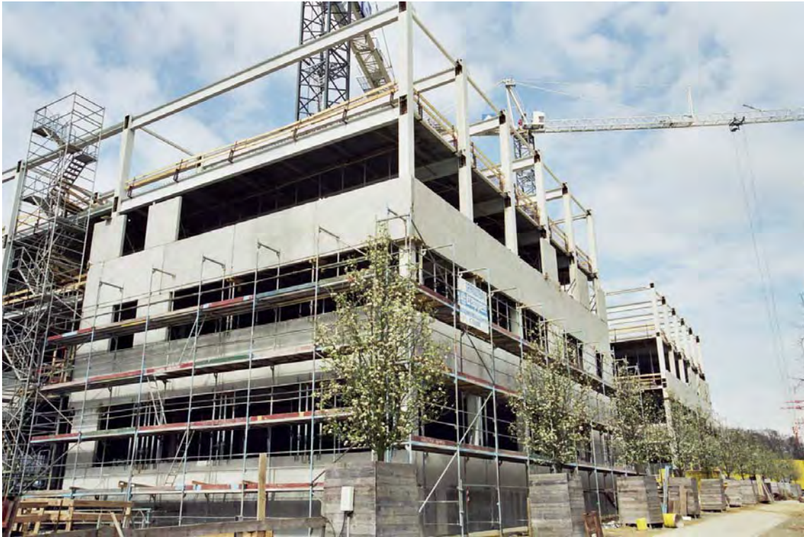
Edificio durante la construcción
