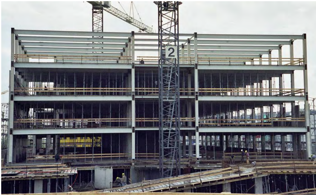
Figura 3.1 Vista lateral del edificio durante la construcción
